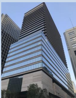
日比谷FORT TOWER
