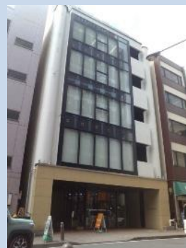
RONGO日本橋ビル
