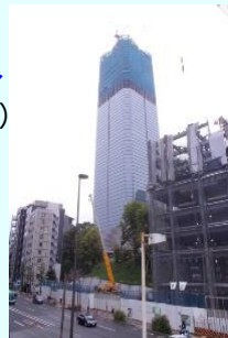
虎ノ門・麻布台プロジェクト(仮称) A街区タワー棟
