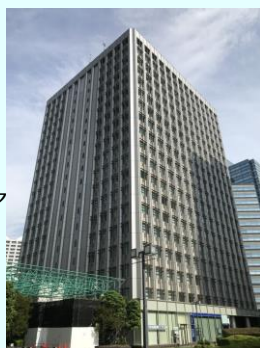
大崎ニューシティ3号館
