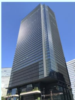
常盤橋タワー
