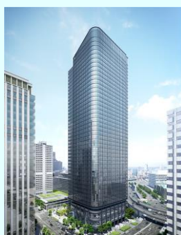
常盤橋タワー
