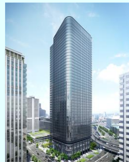
常盤橋タワー
