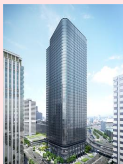
常盤橋タワー
