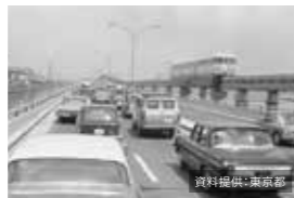
METROPOLITAN EXPRESSWAY 輸送力を一気に高めた首都高速道路の建設
